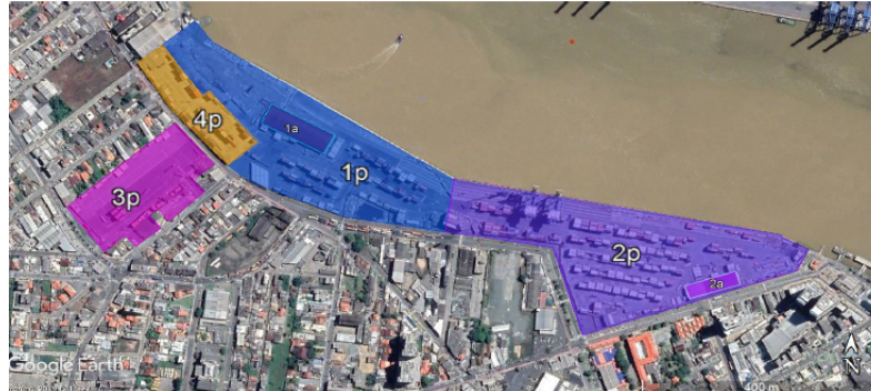
Figura 8 - Instalações de Armazenagem do Porto de Itajaí. Fonte: SPI sobre imagem Google Earth (2019).
